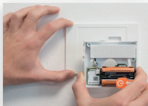
2. LA SONDA presente nel kit sostituisce il vecchio termostato.
