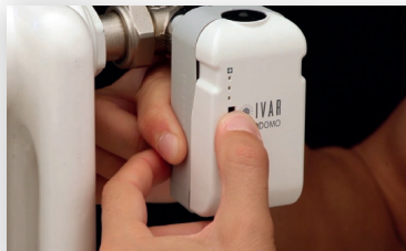
8. RIMUOVERE la testa della valvola, installare l'attuatore e tenere premuto il pulsante per creare il collegamento via radio.
