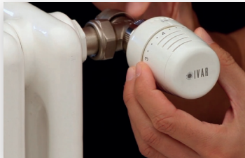
8. RIMUOVERE la testa della valvola, installare l'attuatore e tenere premuto il pulsante per creare il collegamento via radio.
