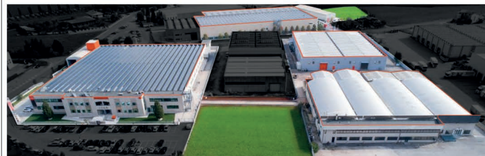
L'area produttiva si estende su quattro siti per una superficie complessiva di 56mila metri quadri
