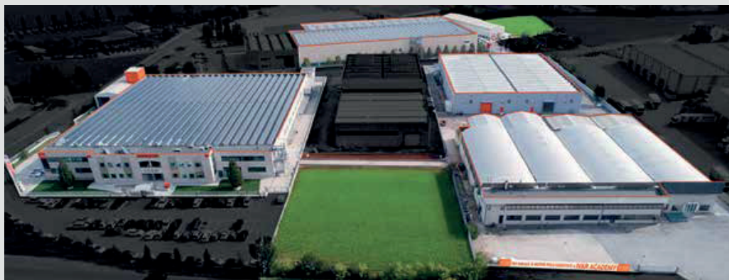
Vista dall'alto dello stabilimento IVAR di Prevalle (Brescia).
