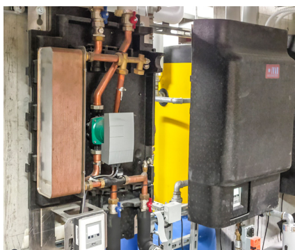
SAP (modello 100 l/min) in cascata completo di tutti gli accessori, installato in centrale termica
